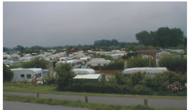
Am 2. Tag des Hochwassers wurde direkt am Deich der höchste Pegelstand gemessen. Das Wasser aus dem Hinterland staute sich jetzt vor den Schöpfwerken, die Pumpen hatten ihre Leistungsgrenze erreicht und schafften es nicht diese Mengen an Wasser in die Ostsee zu pumpen.
