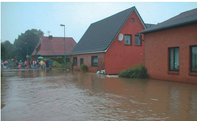
In Schönberg konnte die Kanalisation die enormen Wassermassen nicht mehr aufnehmen sie ergossen sich über die Strassen und unterspülten die Fundamente von Häusern
